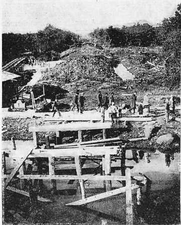
Большевики прокладывают новые дороги через леса и болота. На снимке — постройка моста через реку. Владынасыпь дорожного полотна. (Поти (Абхазия), Колхидстрой) Фото А. Шайхета
